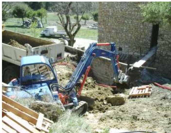
Une pelleuse creuse les fondations de la chaufferie
