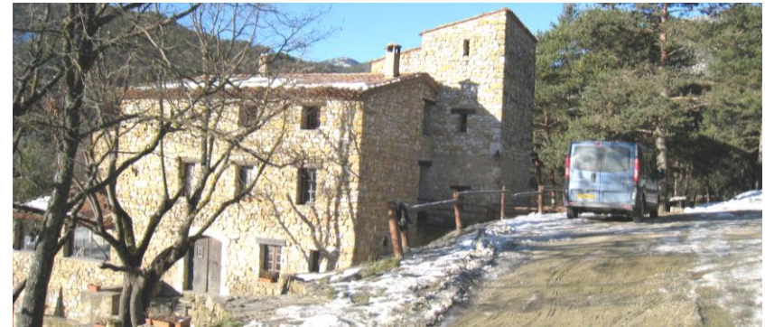
Vue côté Est où se construira l'extension du bâtiment
